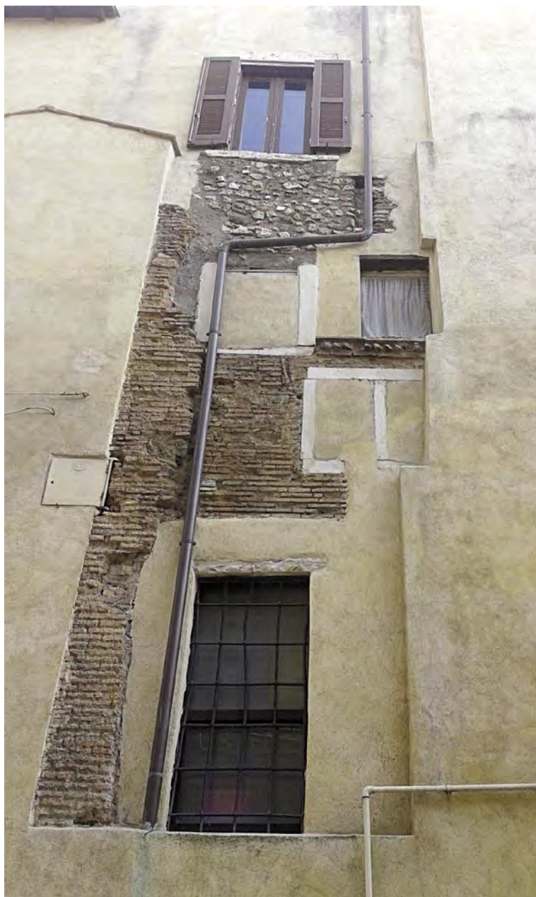
Fig. 4 - TIVOLI, murature medievali e cornice a denti di sega attribuite alla chiesa di S. Barbara (foto Autore).
