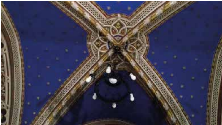
Figg. 15-16 - Sacro Speco, vista della pseudo volta del Coro realizzata dal Casaretto, intonacata e dipinta nella parte sottostante.
