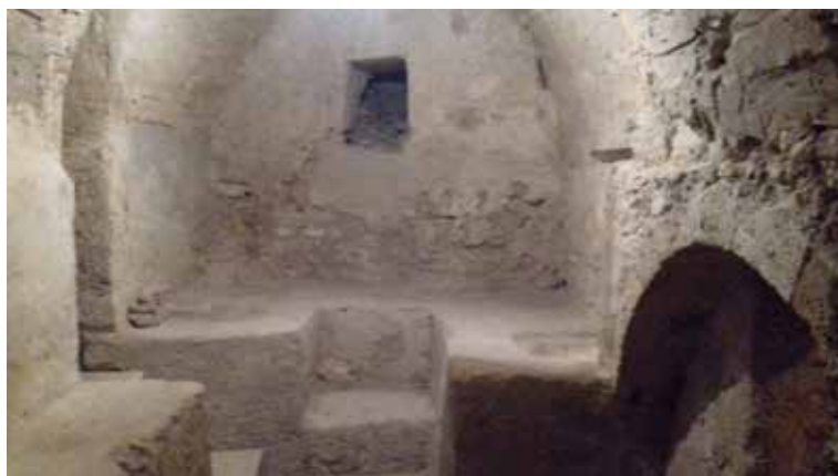
Fig. 13 - Spazio adiacente (3): a sinistra la porta, sul fondo una piccola apertura che immette verso un'intercapedine. A destra muratura ad arco, con a lato una botola.
