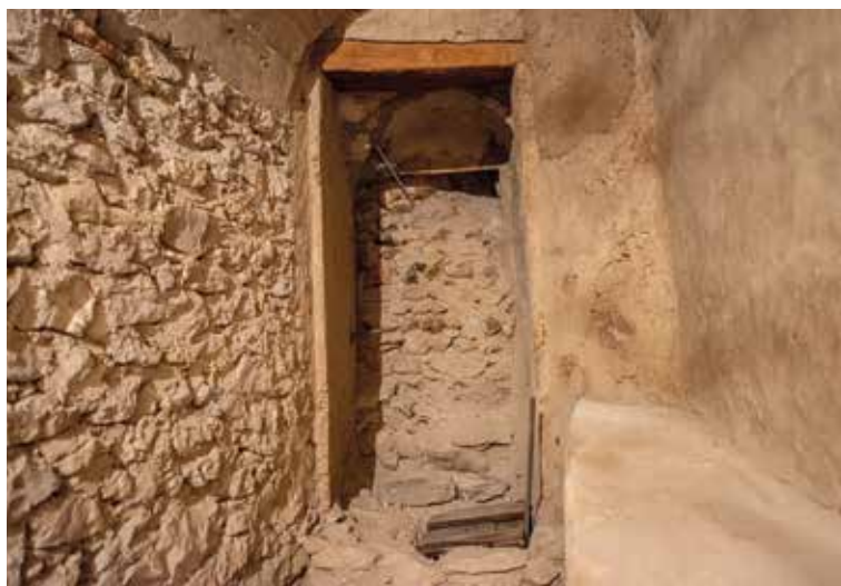
Fig. 15 - Chiusura di antica apertura (4). Foto che guarda verso il sottostante “Coro del Casaretto”, anticamente Cantinone , come riportato dalle Cronache. In primo piano, sulla destra, una caditoia che arriva fino al livello sottostante.
