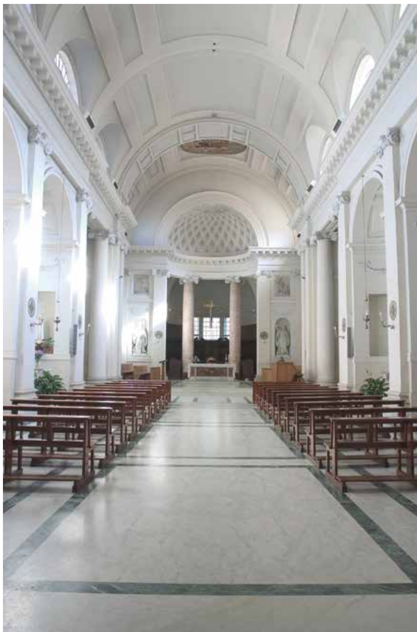
Fig. 19 - La volta con le lunette realizzate per un'ampia illuminazione.
