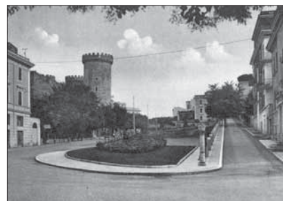
Sistemazione della zona di viale Mannelli dopo la soppressione del trenino Roma-Tivoli.
