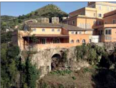
Intuibile la larghezza del Ponte San Rocco dopo la ripulitura
