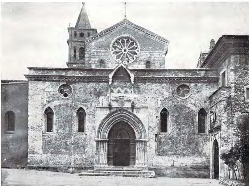
Aspetto attuale - Particolari costruttivi apparsi sotto l'intonaco. I rosoncini e gli archetti acuti delle feritoie sono della fine del sec. XIX.
