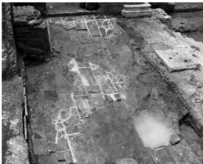
Fig. 4 – Tivoli. Villa Adriana. Palestra, sala ipostila: pianerottolo, particolare del pavimento a schema isodomo (foto Z. Mari).
